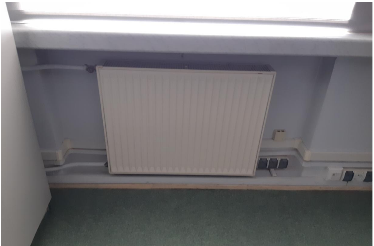
Zdj. nr 8. Widok grzejnika i część parapetu w sali nr 42
