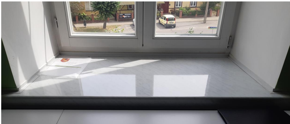
Zdj. nr 5. Parapet w sali nr 32
