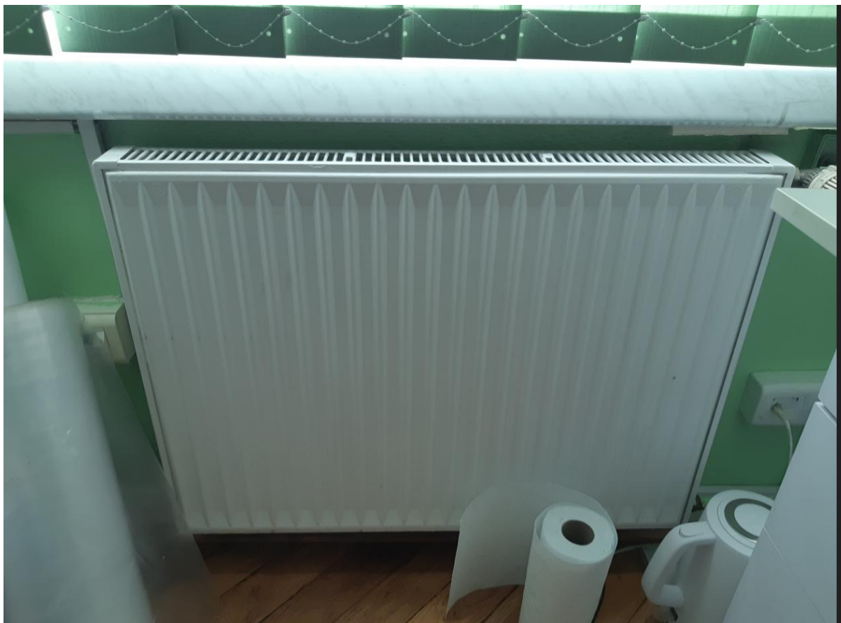
Zdj. nr 4. Widok grzejnika i część parapetu w sali nr 32
