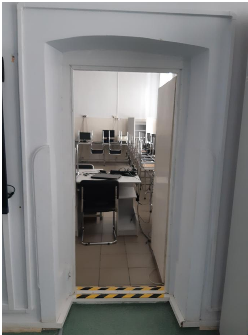
Zdj. nr 9. Widok otworu drzwiowego do zamurowania pomiędzy salami (42).
